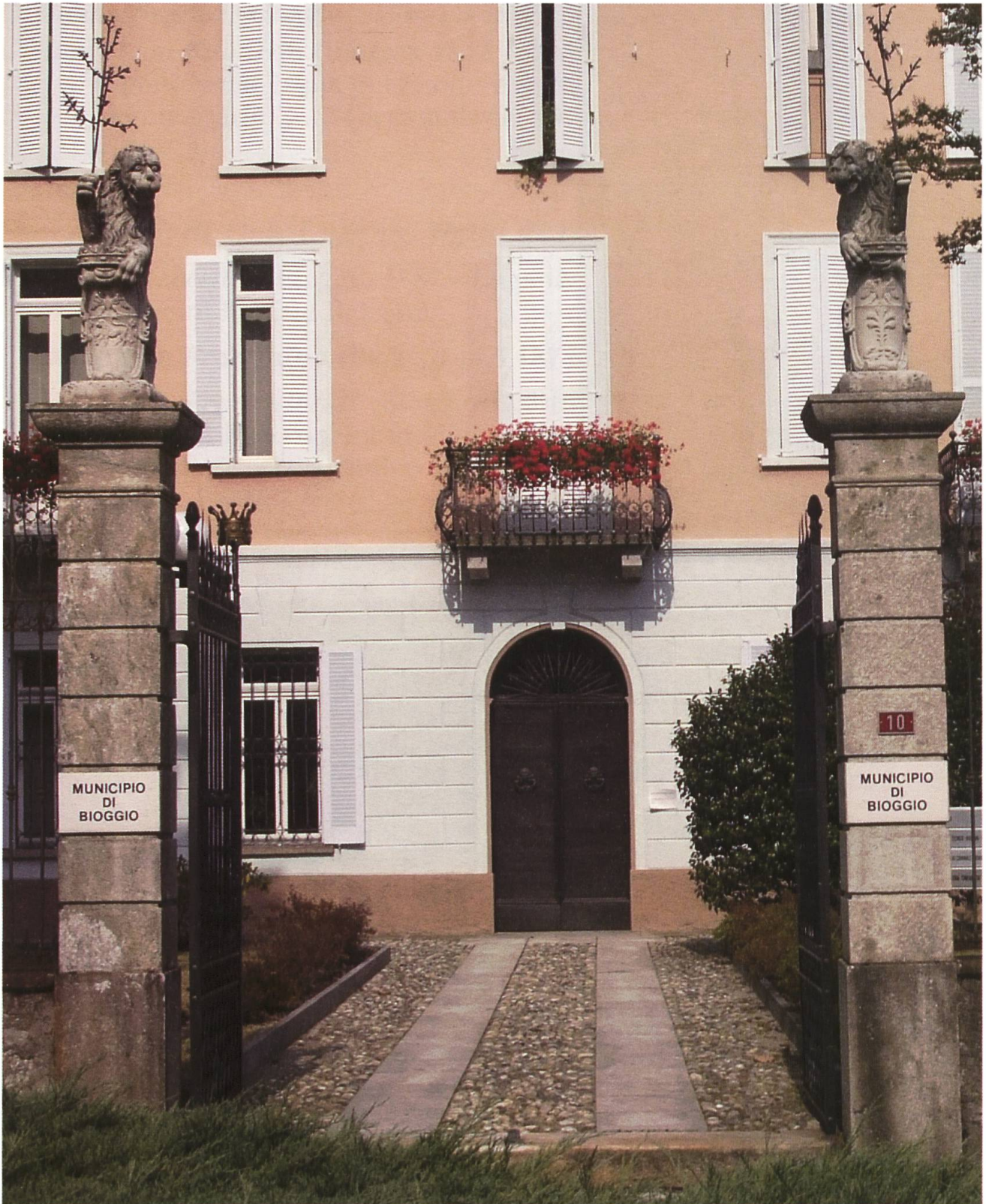
Ingresso principale del palazzo Rusca a Bioggio, ora sede del Municipio
