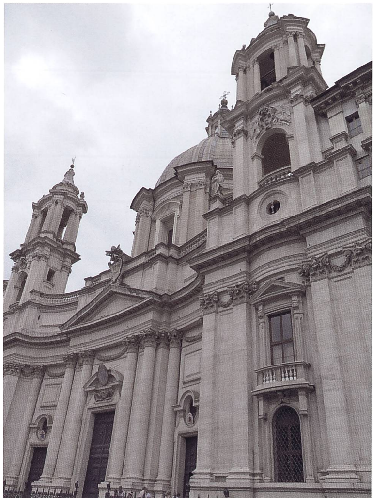
Borromini in Piazza Navona
