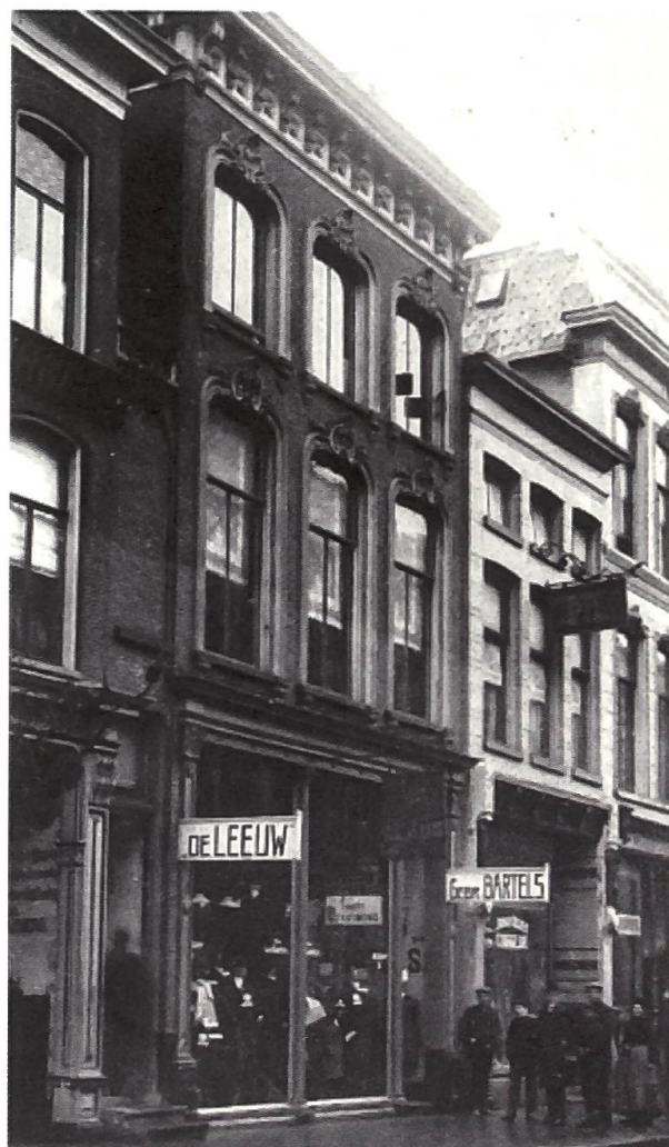
Fig. 8 Sede della ditta «Balli, Selva & Co.» situata al n° 328 della Heerestraat (2ª da destra).
