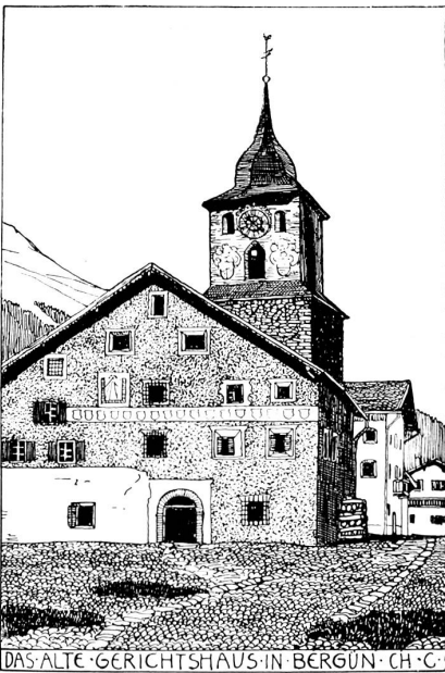
DAS ALTE · GERICHTSHAUS · IN · BERGÜN · CH · C
