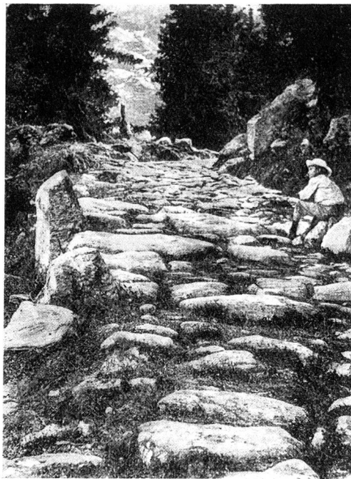
Castelmur-Straße 1387. Plattenbelag. Casaccia. (Staatsarchiv)
