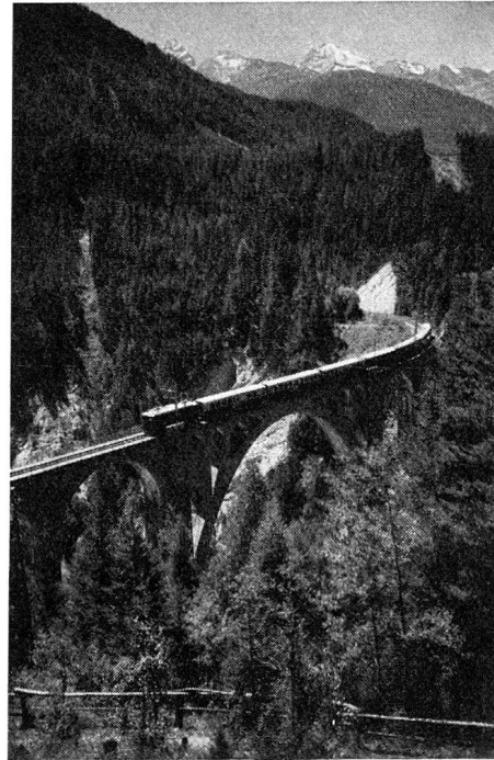
Der Wiesener Viadukt.
