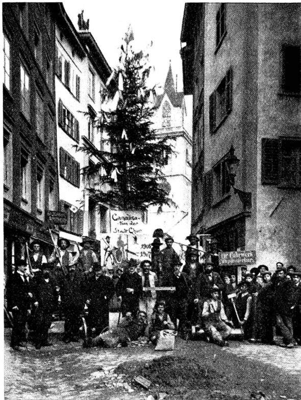
Die Erstellung der Kanalisation in den Jahren 1905-1907 erforderte namentlich in der Altstadt große bauliche Umtriebe.
