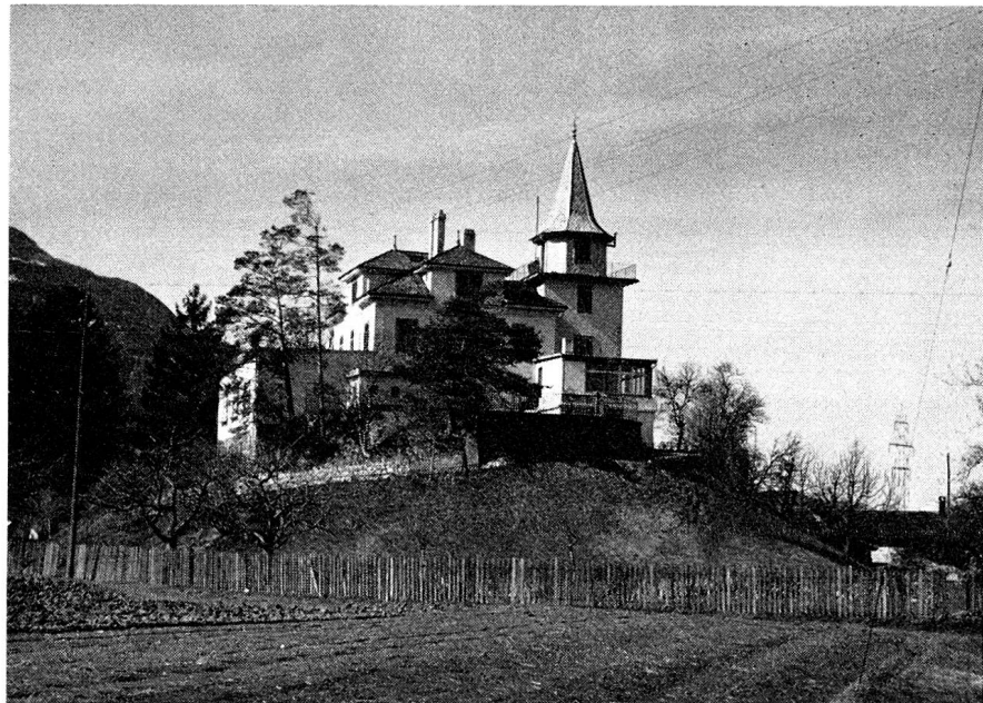
Rheinfels oder Risch'scher Bühl von SW Photo W. Etter-Brunner
