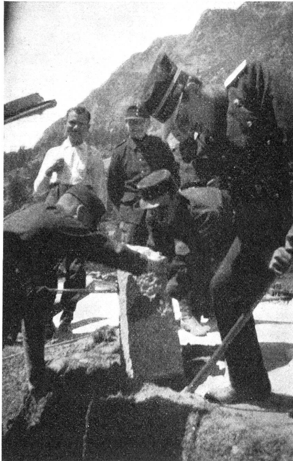
Auch mit 20 km/h kann man Randsteine rammen Qm. Accola prüft seine MS mit dem Hebeisen
