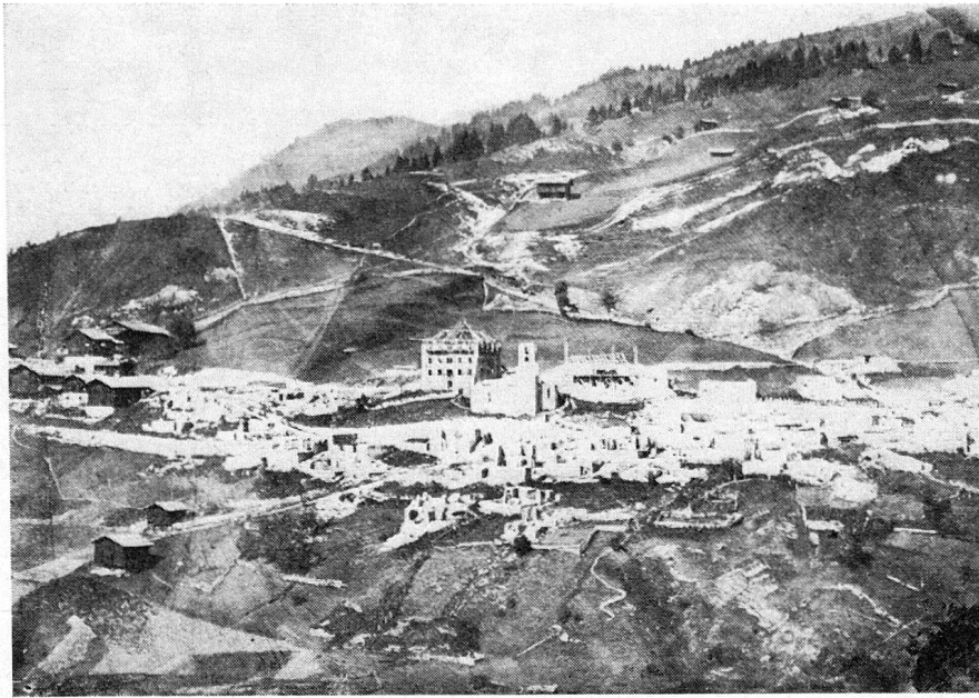
Abb. 1 Das Ruinenfeld im Frühjahr 1875. Das Sprecherhaus im Wiederaufbau. Links der verschont gebliebene westliche Dorfteil.
