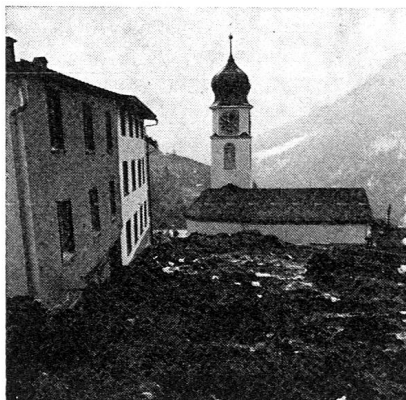
Bis an die Kirchenwand stießen die Schuttmassen vor.
