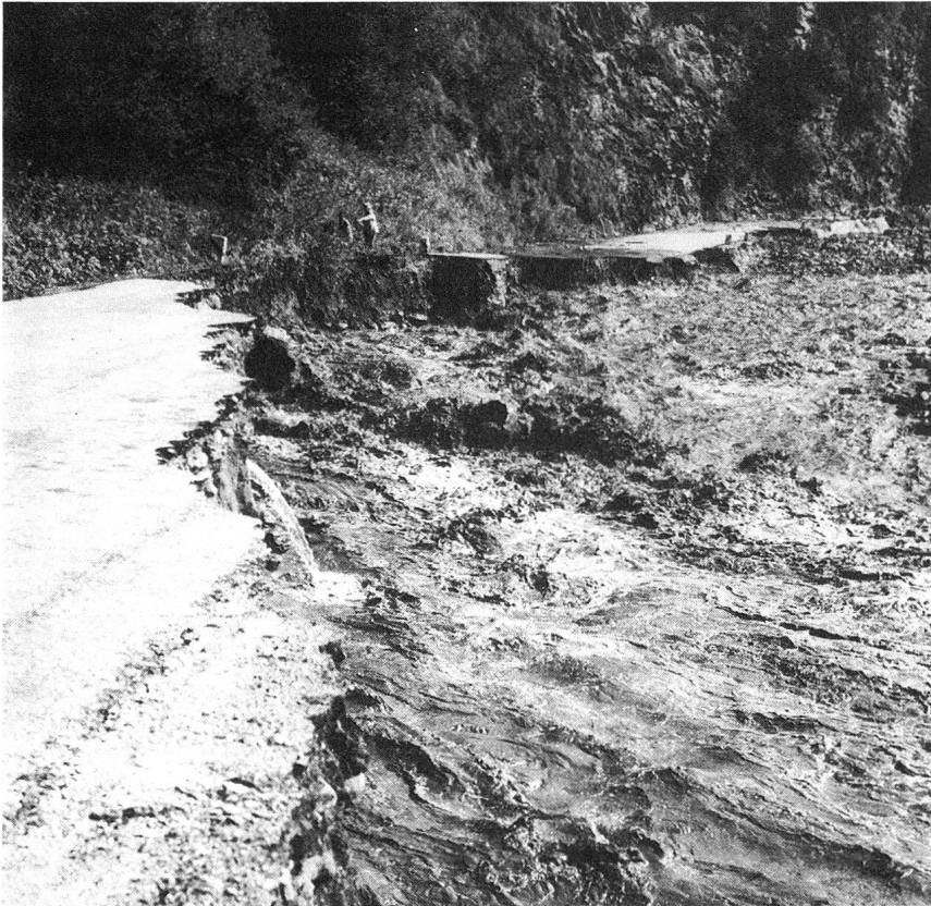
Rüfe «Rieiner-Tobel», 31. Juli 1967, Aufnahme vom 10. August 1967. Immer noch führt der Glenner eine beachtliche Wassermenge, und die Valslerstraße ist auf eine erhebliche Länge weggerissen. Foto H. Rostetter, Ilanz
