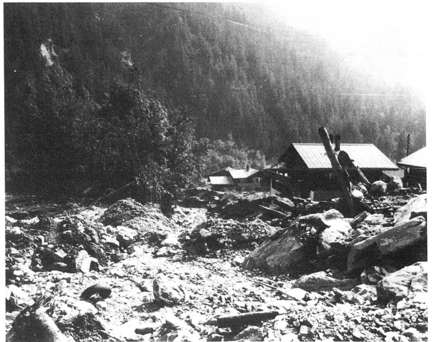
Unwetterkatastrophe in Molinis vom 29. Juli 1980. Gewaltige Steinblöcke, Wasser und Schutt richteten im Schanfigger Dorf Molinis enorme Schäden an. Foto Kant. Tiefbauamt GR, Chur
