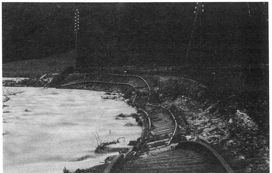
Hochwasser 1910. Hier hat das Hochwasser der Landquart gründliche Arbeit geleistet. Bei Fideris wurde der Damm der RhB unter dem Geleise weggespült.
