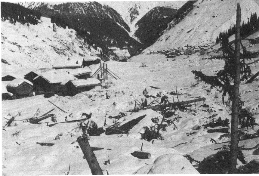
Lawinenniedergang in Medels, 1951. Mit den Schneemassen wurde viel Holz aus dem zerstörten Wald bis zu den Gebäuden mitgeführt. Foto Forstinspektorat GR, Chur
