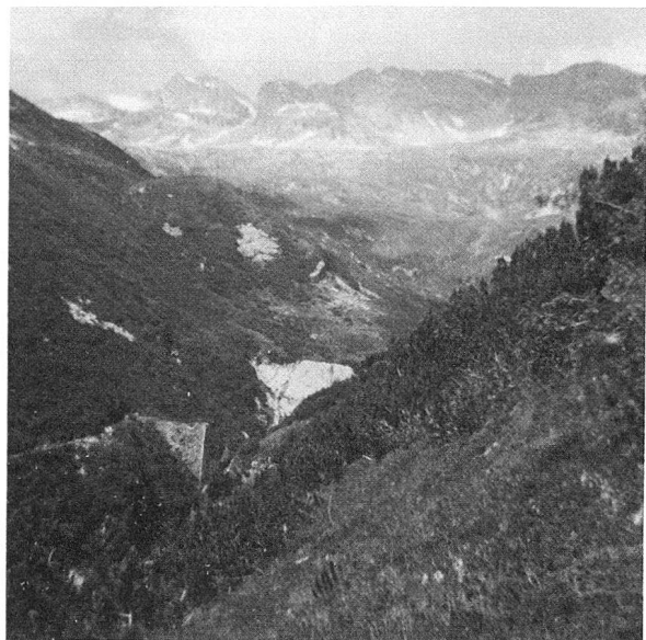
Die letzten Spuren der Ponte
