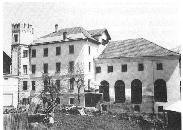
Gemauerter Stall mit wohlproportionierten Fassadenöffnungen in Sent.
