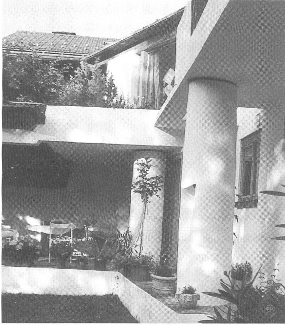
Echte Olgiati-Säule: Zentrierendes, nicht tragendes Element.
