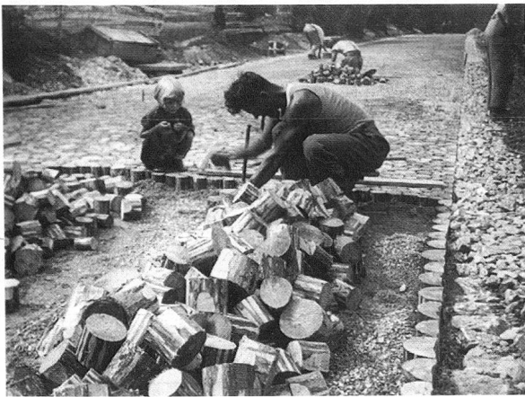
Abb. 5: Holzpflasterung bei Cazis im Jahr 1936.
