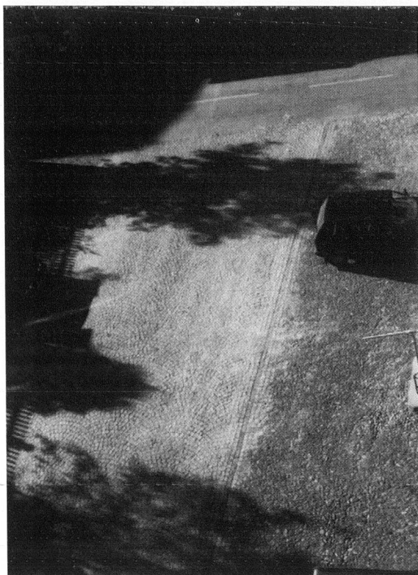
Abb. 17: Lavin. «Plaz Grond» in fertigem Zustand. Sichtbare Übergänge zwischen neuer Bogenpflästerung und altem Bollensteinbelag.
