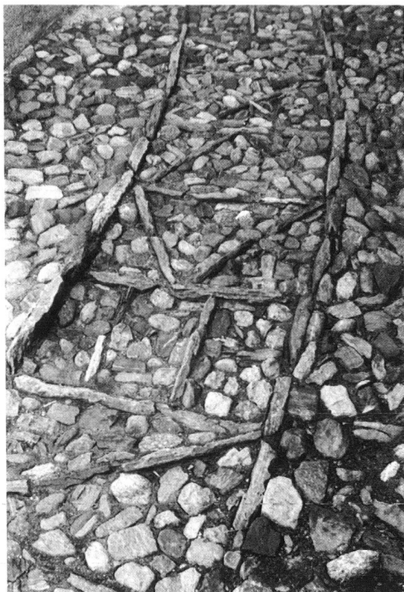
Abb. 22: Guarda. Rampe zur Hauseinfahrt eines Bauernhauses.
