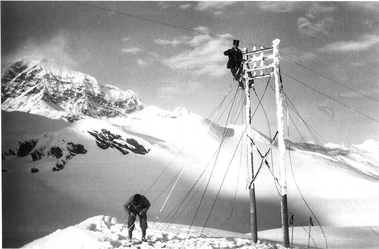
Störungsbehebung am San Bernardino-Pass, Januar 1939. Die Freileitungen waren besonders im Gebirge extremen Witterungsbedingungen ausgesetzt. (Foto Telecom PTT Chur).
