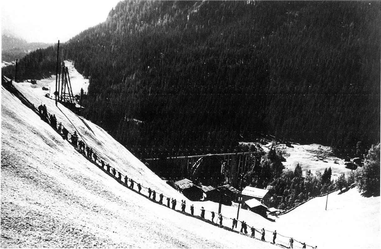
Kabellegung Chur–Arosa, 1946. Links über dem Langwieserviadukt eine Freileitung, wie sie vor dem Kabelbau zuhauf die Landschaft «zierten». (Foto Schweiz. PTT-Museum Bern).
