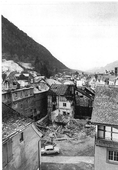
November 1970 bis Januar 1971, Abbruch der Magazinbauten. (Foto: Th. Hartmann)
