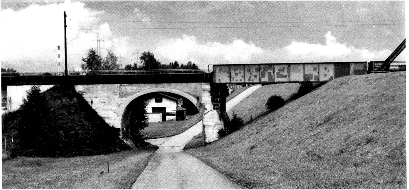
Eisenbahn-Rheinbrücke bei Buchs. Unter dem Bogen befand sich im Zweiten Weltkrieg eine Holz-Baracke als sog. Kantonement des Grenzschatzes IV/284. Als Kpl. war Hans Guntli dort im Dezember 1944 Wach-Kdt. (Foto H. G., 2000)
