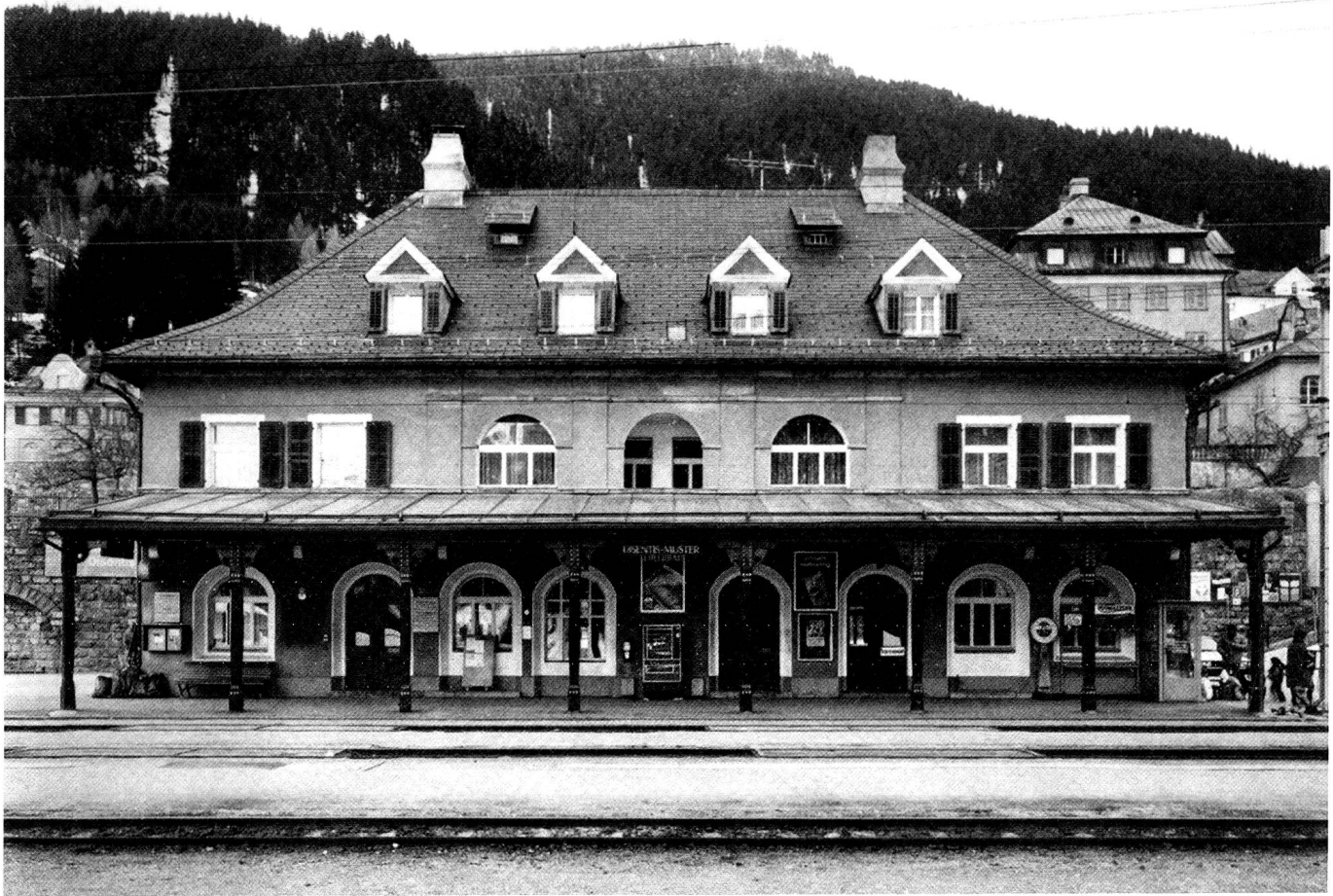
Aufnahmegebäude Bahnhof Disentis/Mustér, 1912, Geleiseseite. (Quelle: Dosch 1984, S. 79)
