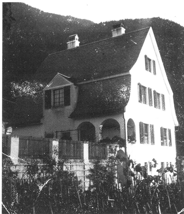
Das Haus Reta an der Bondastrasse 6 in Chur ein bis zwei Jahre nach seiner Fertigstellung im Herbst 1913, Eingangsbereich mit offener Vorhalle. In der Mauer, welche den Vorplatz zum Eingang vom Rebberg trennt, sind gerichtete Flusstaine gesetzt.
