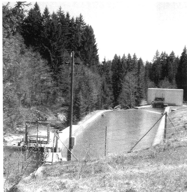
Wasserfassung Punt Gronda mit dem modern gestalteten Schieberhaus. (Foto E.C. Mai 2003)
