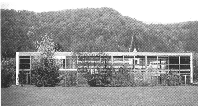
Ein Schweizer Beispiel für die damalige Rezeption der Mies'schen IIT-Grammatik ist das Schulhaus Kleinlützel (1959/60) des Solothurner Architekten Franz Füeg. (Quelle: Roland Wälchli: Impulse einer Region. Solothurner Architektur 1940–1980, Solothurn: Architekturforum im Touringhaus, 2005, S. 119)
