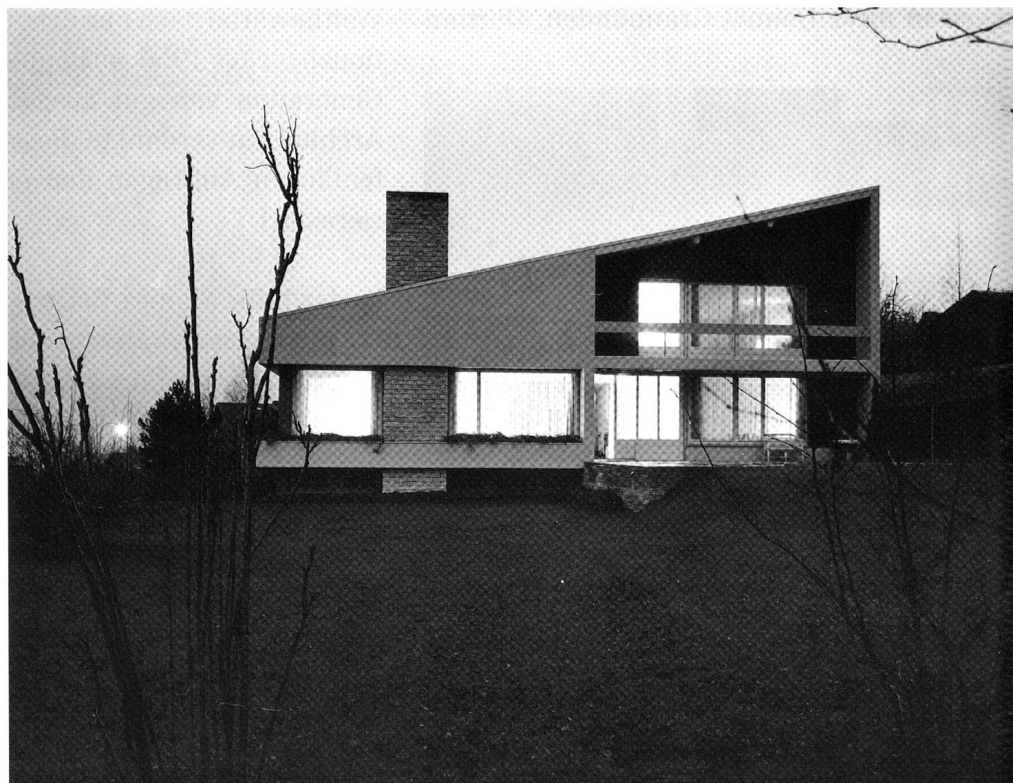
Das Gesellenstück: Für ihre Eltern baute Monica Brügger 1959 in Chur ein Haus. (FRAK, WaMB)
