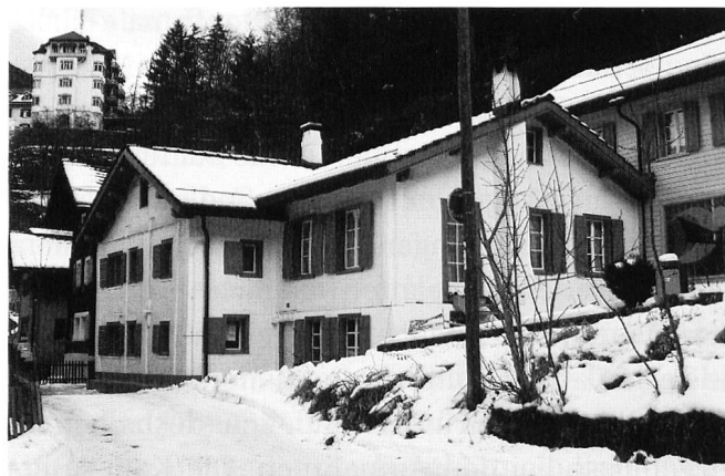
In diesem Haus in Araschgen befand sich das Restaurant «Winkel». Der Saal war ein Anbau an das kleine Wohnhaus von Luzi Brüesch. Das Lokal diente später dem katholischen Gottesdienst. (Bild G. Jäger, 2005)
