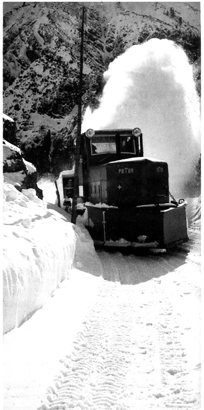
Der vorgespannte Pflug gehörte viele Jahre zur winterlichen Ausrüstung eines jeden Postautos im Berggebiet, und wenn dies nicht genügte, kam die Schneeschleuder der Post zum Einsatz, hier am Ofenpass um 1950. (Quelle: Fotoalbum von K. Gächter, in Pb.)
