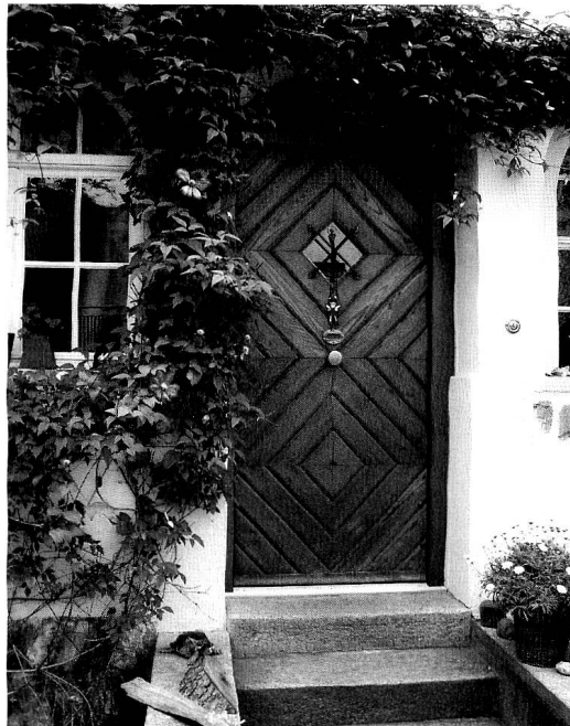
Eingang zum Haus Erni, Nordseite. (Foto P.L. 2009)
