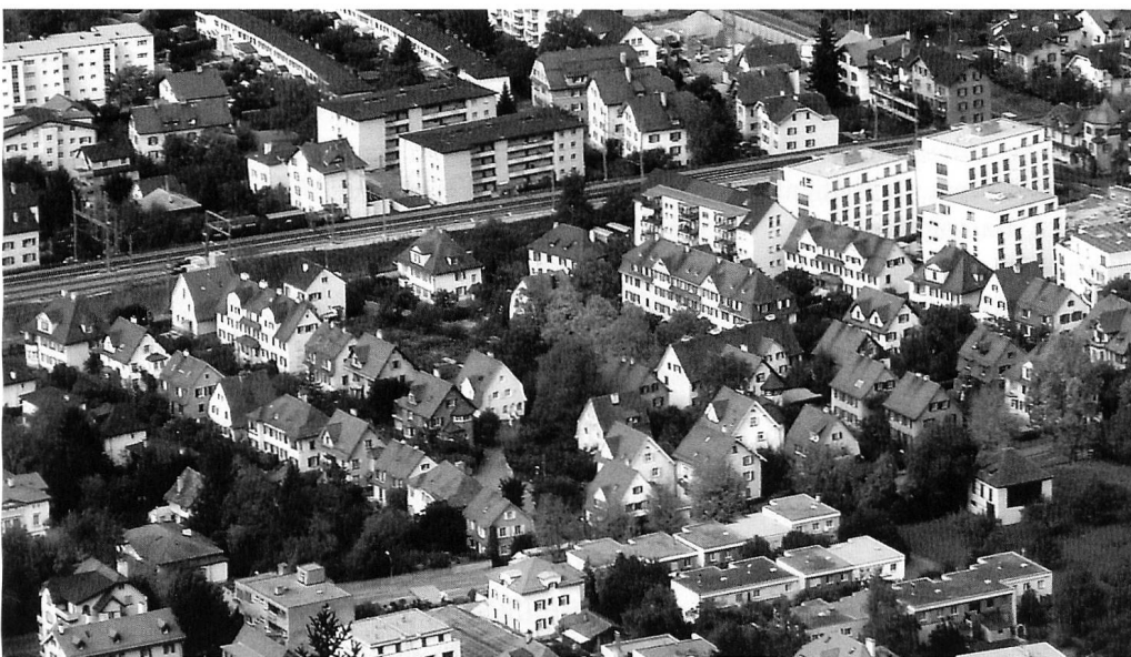
Das Quartier des Stampagartens im Herbst 2005, begrenzt im Westen durch die Bahnlinie und im Osten durch die Masanserstrasse. (Foto A. Bürge)
