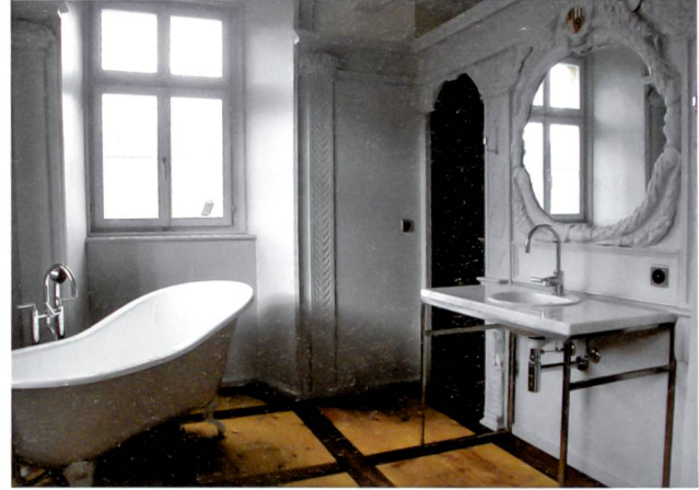
Einbau Bad in ehemaliges Alkovenstübchen im 1. OG.
