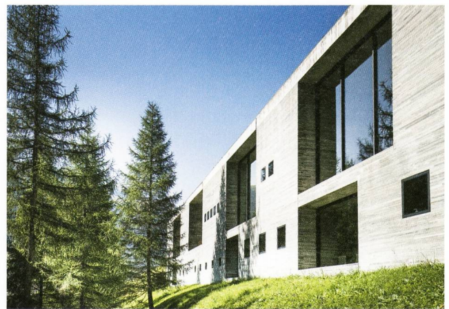
Die nach Nordosten Richtung Dorfausgang ausgerichtete Fassade der Therme wirkt dank der unterschiedlich grossen Fensterflächen leicht und bietet den Badegästen eine unvergleichliche Nähe zur Natur. (Foto: Global Image Creation – 7132 Hotel, Vals, 2017)
