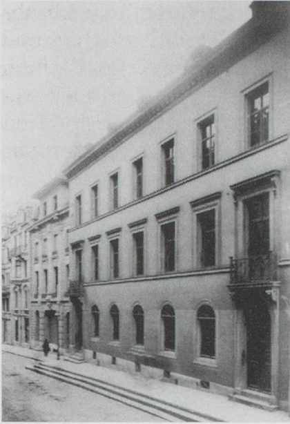
Abb. 6: Haus zum Kettenhof, Freie Strasse 113–115. Neu erbaut 1852, 1902 wegen Straßenerweiterung abgebrochen (Bechburg-Archiv der Familie Riggenbach, StABS PA 841, A 5.4).
