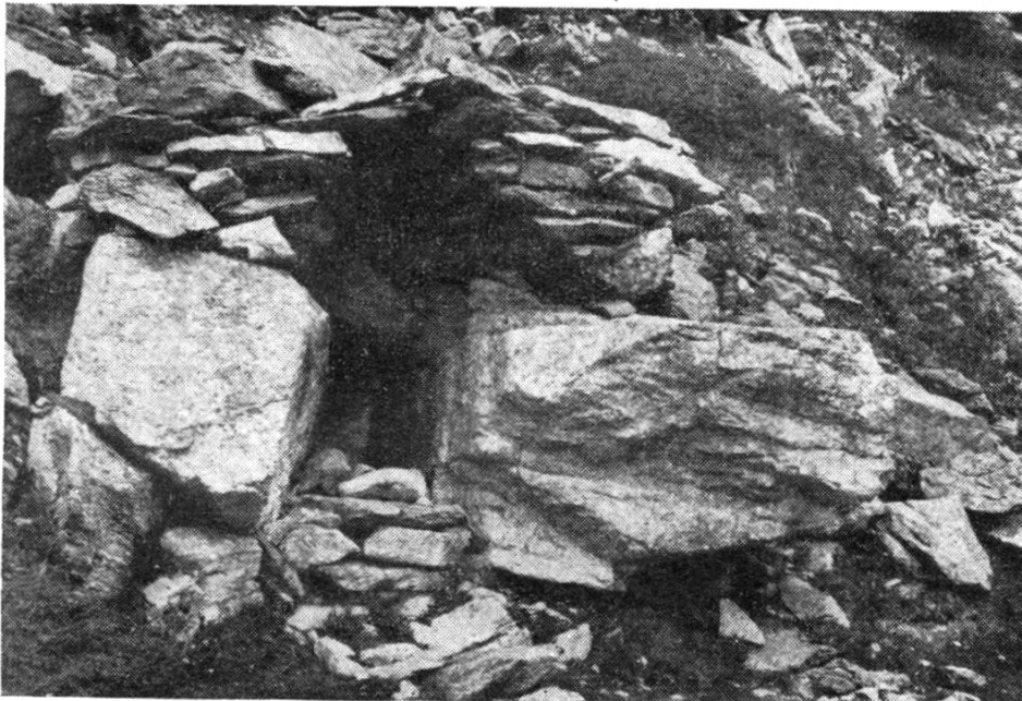
Abb. 7. Hirtenunterstand bei Plan della Teggia im Val Lagonè, 2100 m ü. M. an der Forcola di Livigno. Zeigt das Bauprinzip des falschen Gewölbes in primitivster Form.
