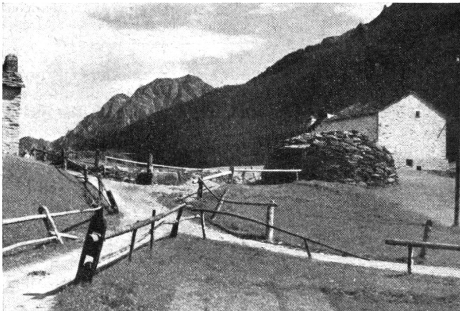
Abb. 5. Große und gut eingerichtete Rundhütte auf Selva, 1450 m ü. M. im Puschlav. Milchkeller, Kühlhaus, 1907 errichtet.
