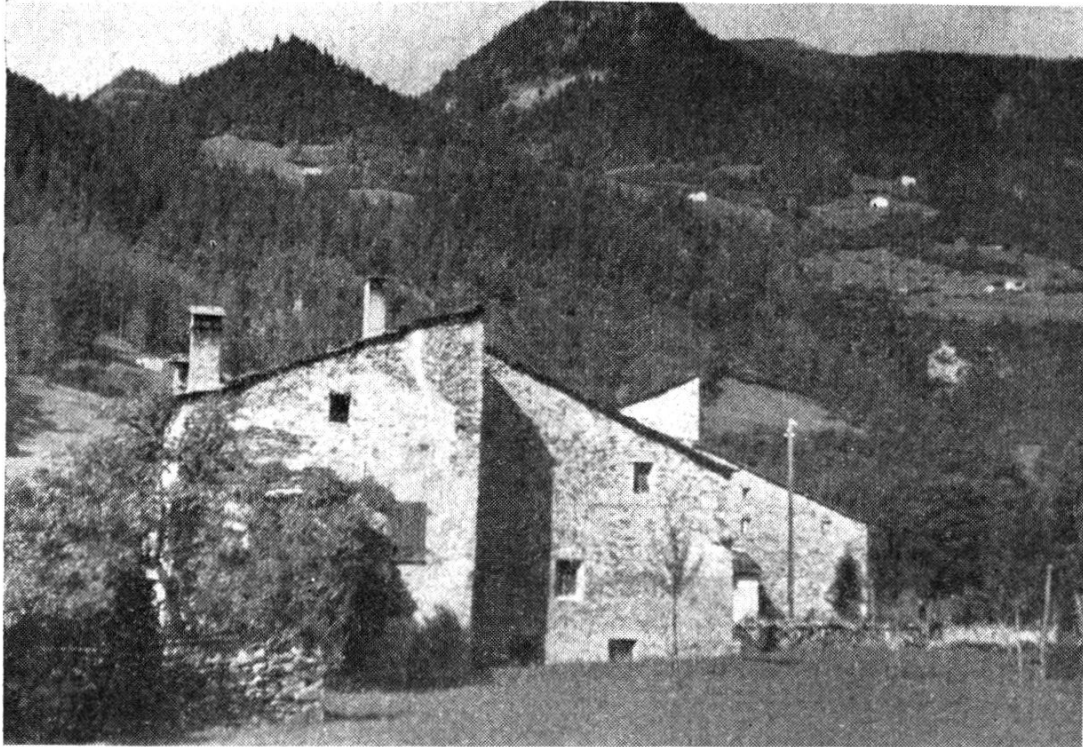
Abb. 1. Bauernhaus von 1701 in Viale, St. Antonio, Puschlav, ca. 1000 m ü. M. In der Giebelfront ist die Gliederung in zwei verschiedene Teile, in das Wirtschaftsgebäude rechts und das Wohngebäude links, sehr deutlich sichtbar.
