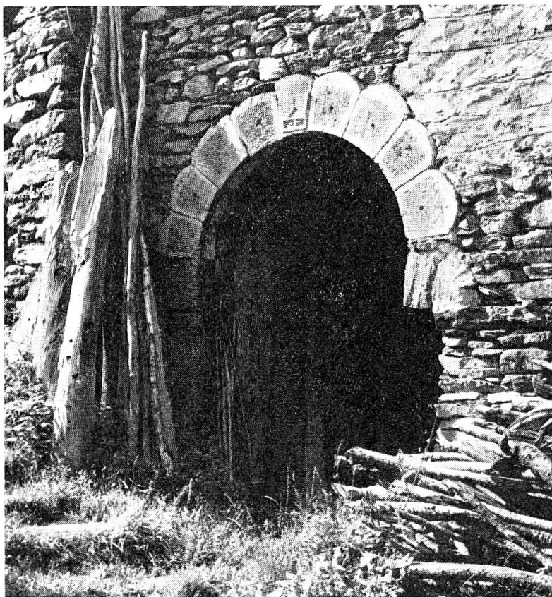
Abb. 4 Soazza. Portal der Schmiede. Gesamtansicht.
