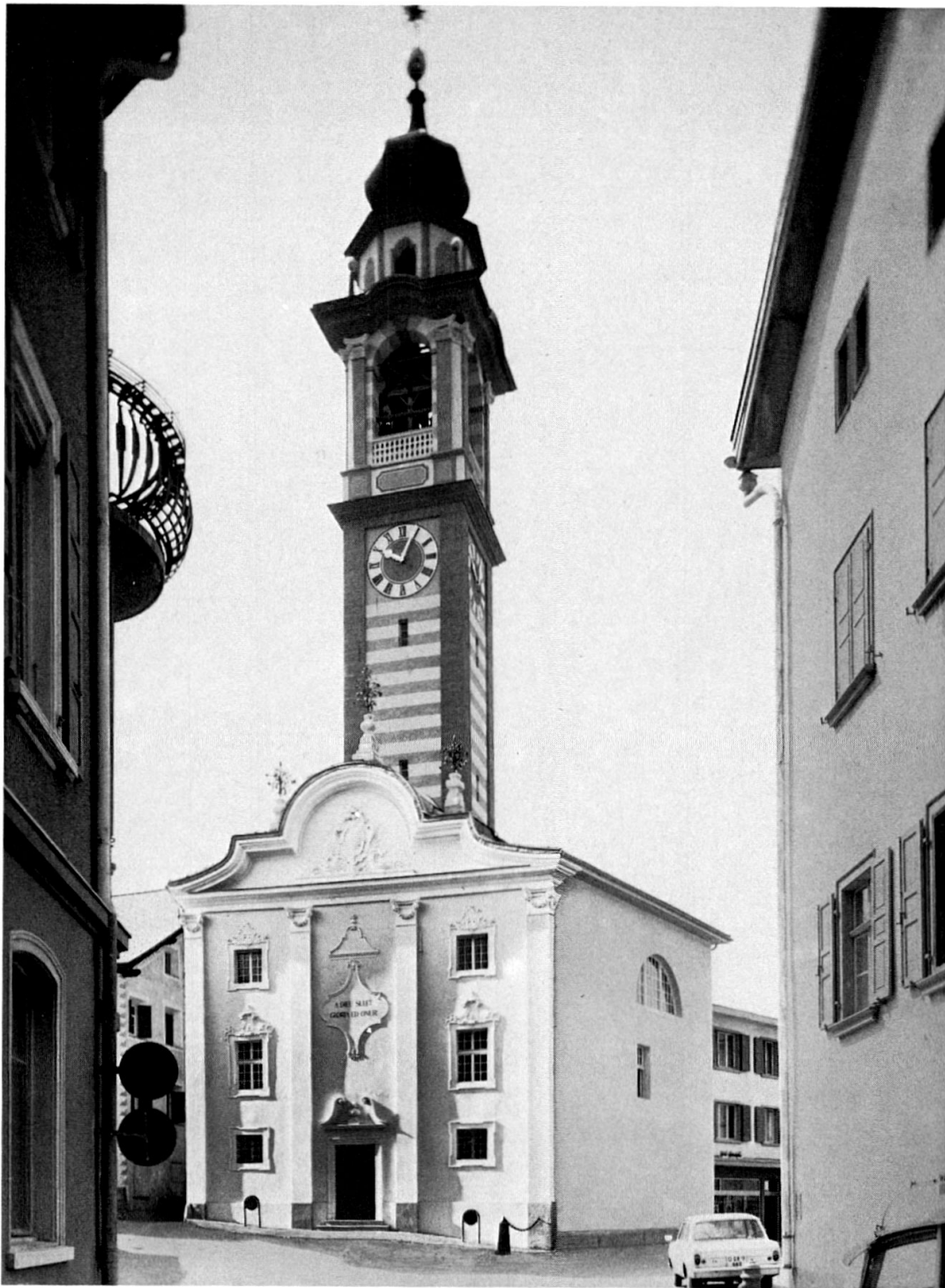
Abb. 1. Kirche am Platz, Fassade und Turm. (Engadin Press Samedan.)
