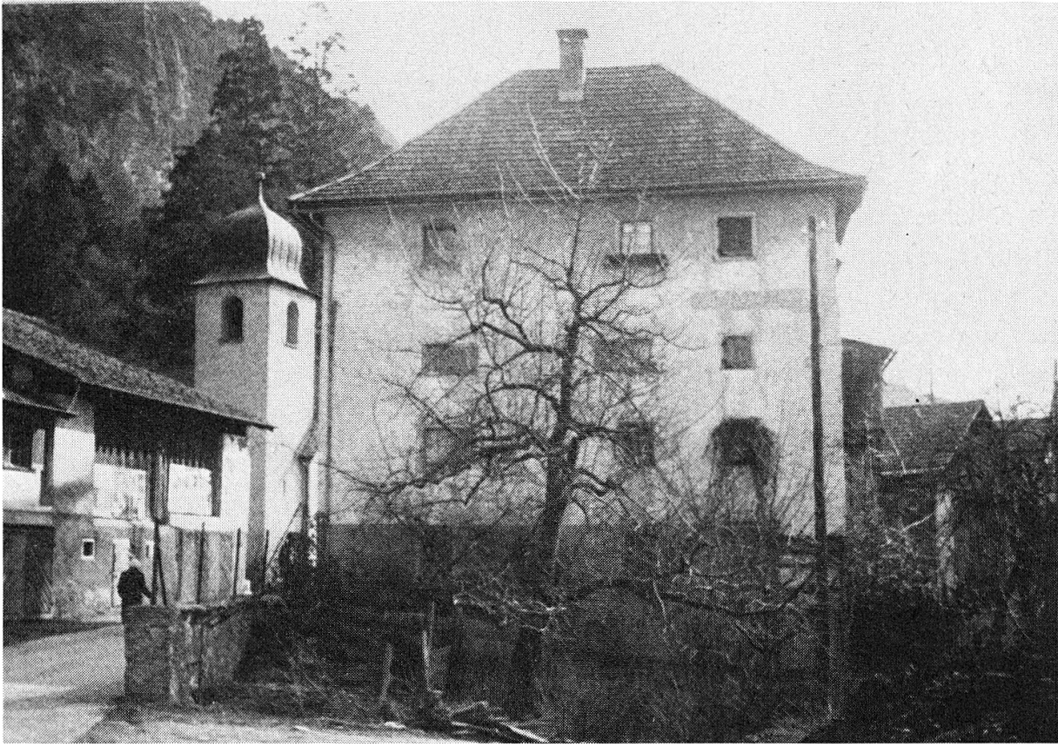
Abb. 3. Das 1734–35 erbaute ehemalige Haus Flisch und die 1740 erbaute Kirche am nördlichen Dorfeingang von Rothenbrunnen.
