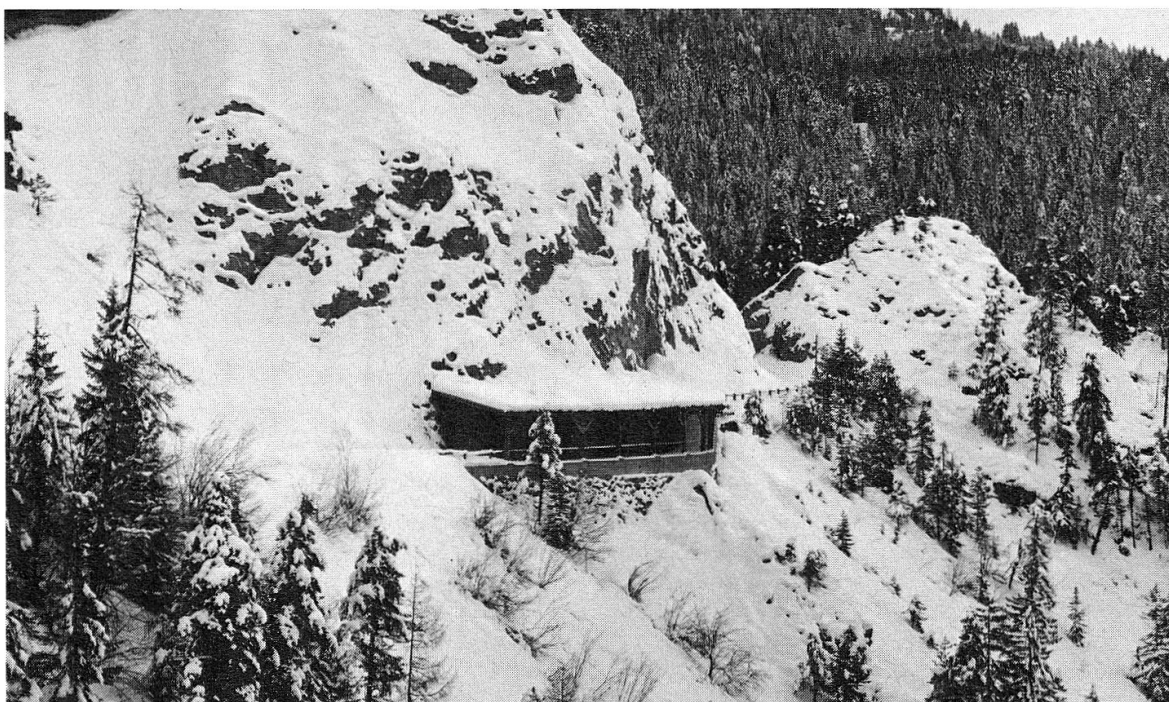
Lavinen- und Steinschlag-Galerie aus Holz. Heute führt hier die Strasse durch den Spitzg Tunnel. Die Galerie ist nicht mehr vorhanden.
