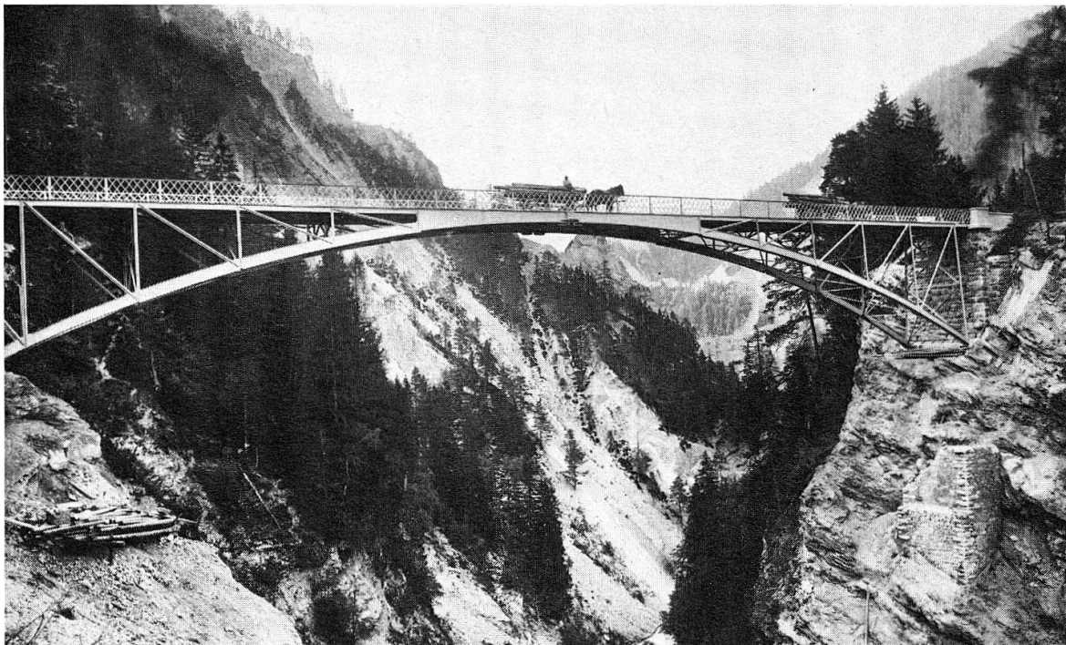
Die neue Eisenbrücke. 1897 kurz nach der Inbetriebnahme. Rechts die Mauerreste des Widerlagers der Holzbrücke.
