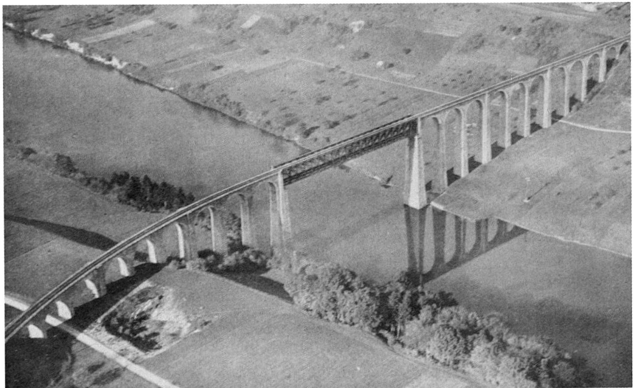
Rheinbrücke bei Eglisau.
