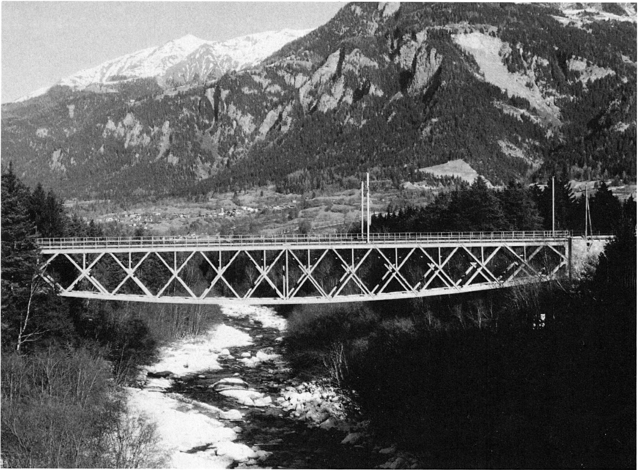
Rheinbrücke Thusis, Zustand Ende 1988.
