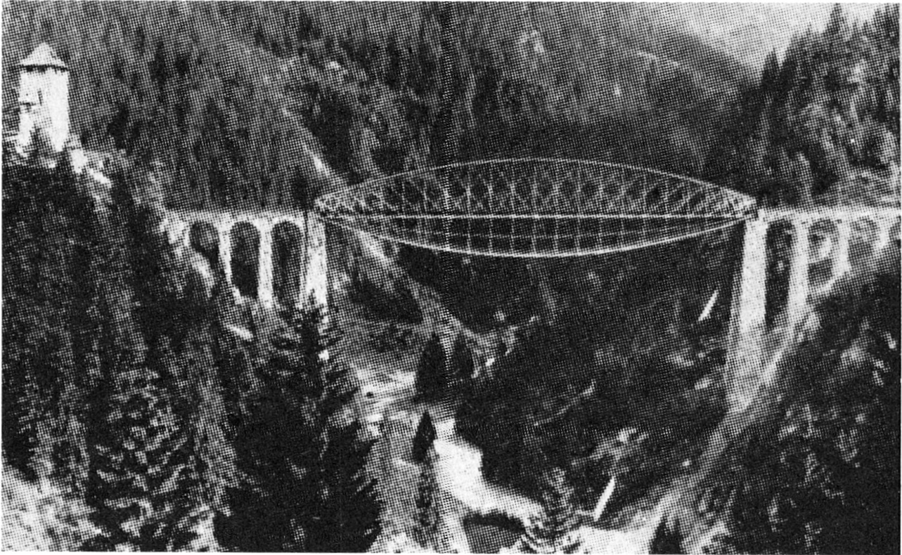
Trisannabrücke der Arlbergbahn.
