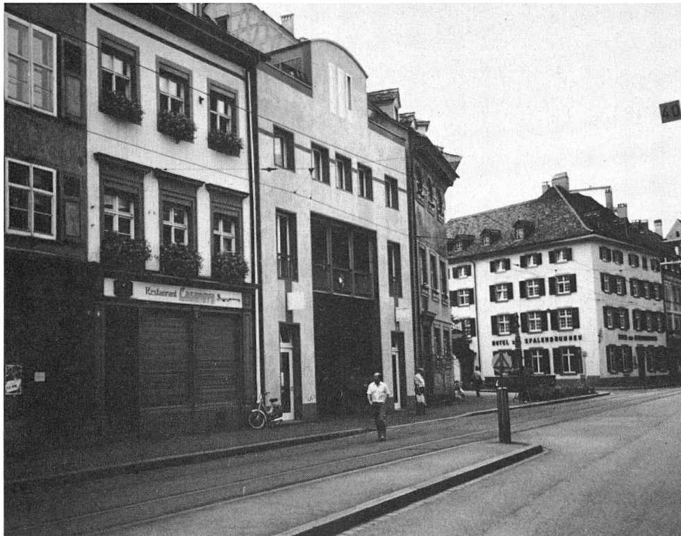
Abb. 10: Basel, Spalenvorstadt 11, Haus mit Eingangstor zur Feuerwehr. U. Marbach und A. Rüegg (Wettbewerb 1981).
