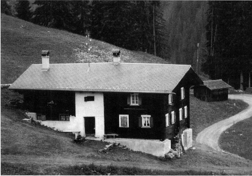
Abb. 12: Ober Gün: Gruoba; Doppelhaus mit gemauerter Mittel- korridorwand
