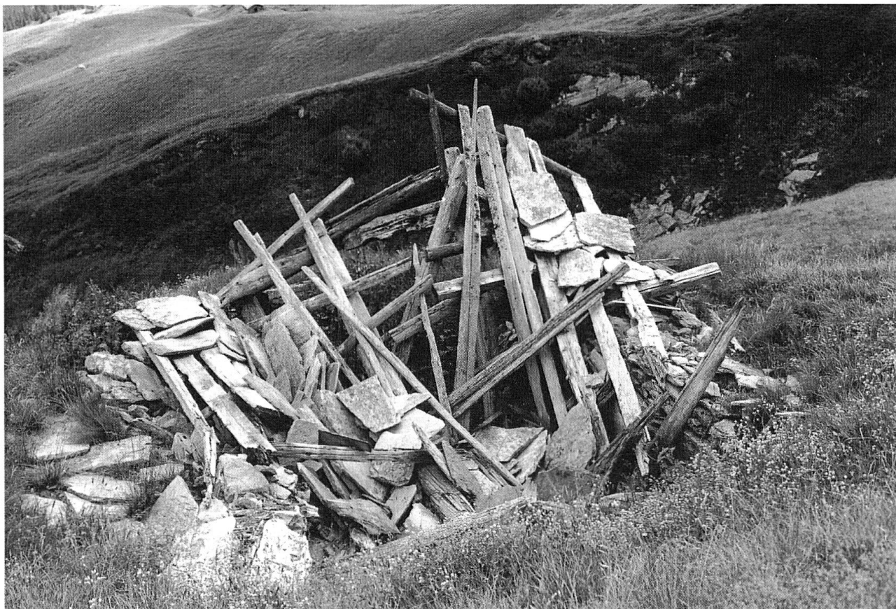
Abb. 26: Eingestürztes Dach eines «Heutachlis»; Zana
