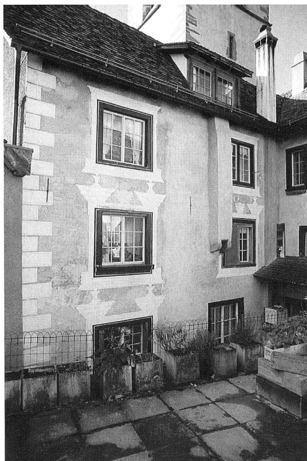
Haus Rainolter, rückwärtige Fassade. (Foto des Verfassers)
