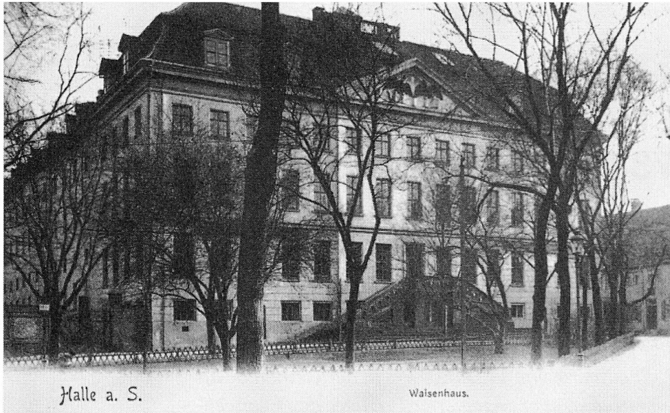
Das Waisenhaus in Halle (Hauptgebäude). Seit 1990 werden die Franckeschen Anstalten grundlegend renoviert.
