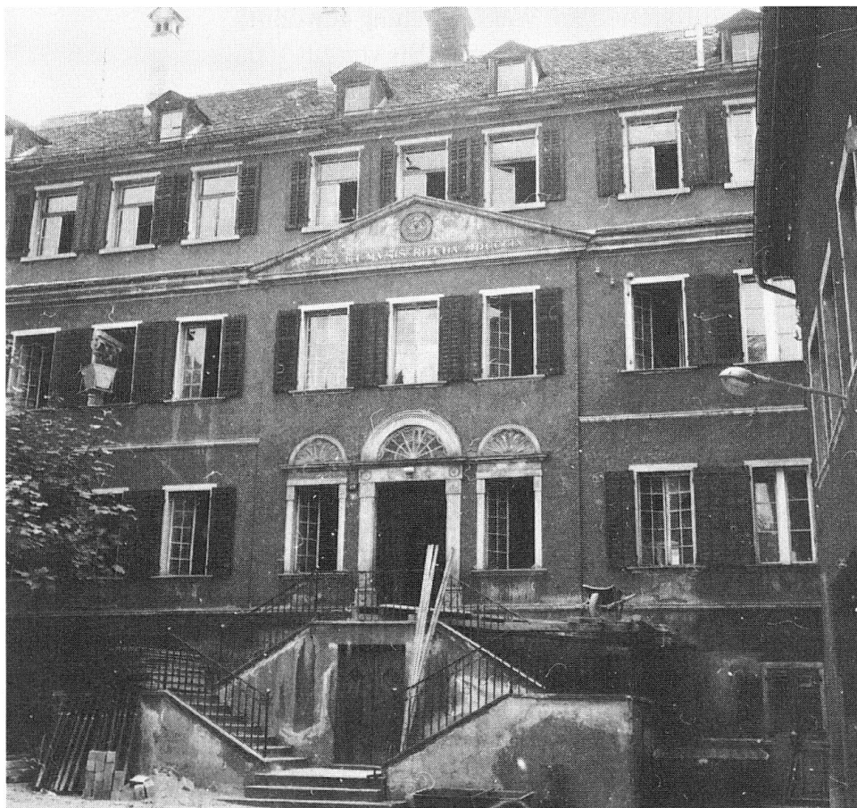
Mittelteil des Klosters St. Nicolai. Das Kloster wurde mehrfach umgebaut, ein Teil davon dient noch heute als Schulhaus (Foto Denkmalpflege).
