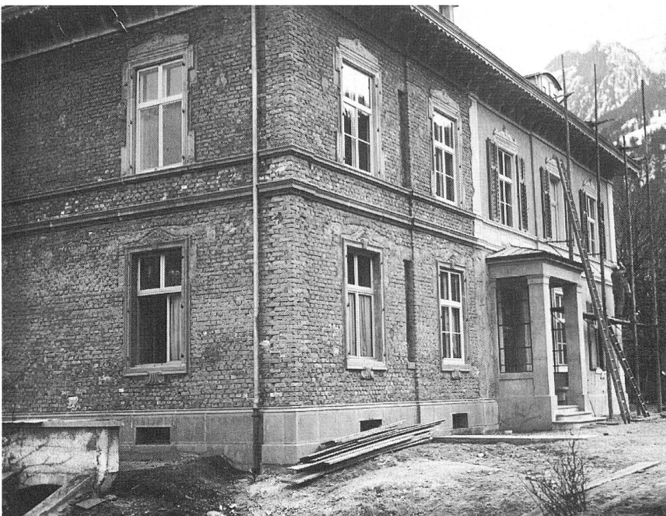
1922/23 während des Umbaus
