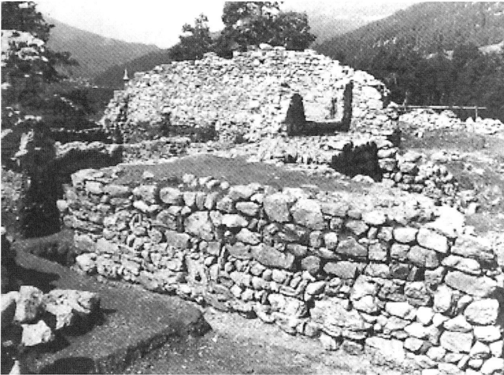
Schiedberg (Sagogn), Zustand nach den Ausgrabungen. Im Vordergrund Fundament des Hauptturms (12. Jahrhundert), dahinter Mauerreste des Palas (13. Jahrhundert). Blick gegen SW.
