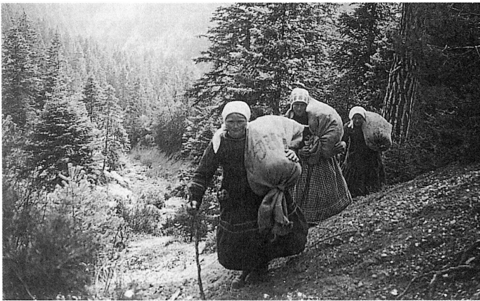
Bewässerungsarbeit war auch Frauenarbeit: Kanalbau im Wallis um 1935. (Bilder: Actes du colloque international sur les bisses 1994, in: Annales valaisannes 70/2e série, 1995, S. 335)
