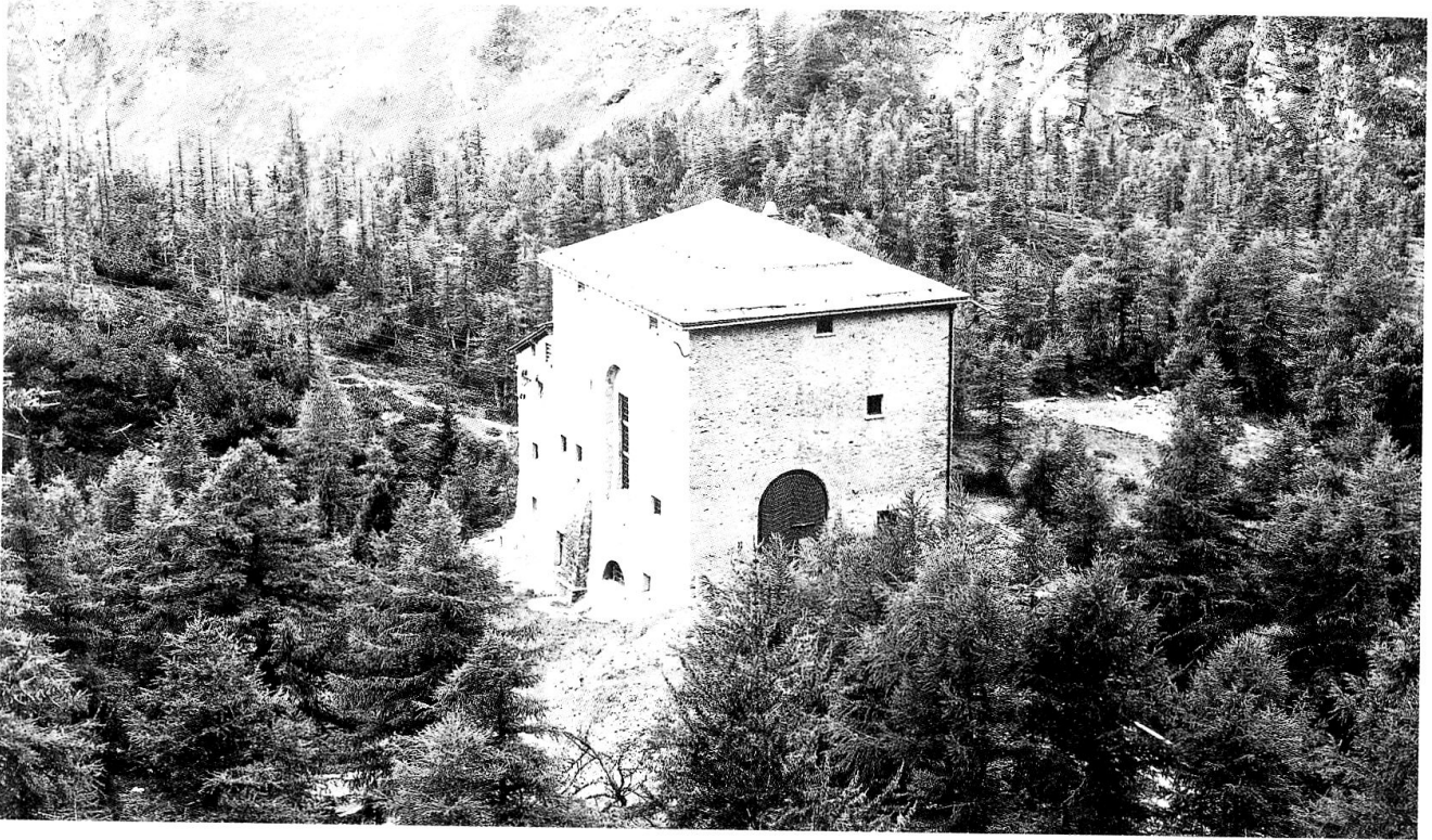
Die Kraftwerkzentrale Palù. (Foto: Christian Kerez)
