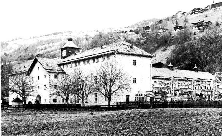
Das Kraftwerk Küblis. (Foto: Jürg Ragetti)
