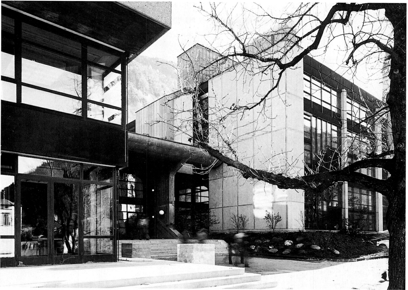
Der Haupteingang zwischen Aula und Naturwissenschaftstrakt.
