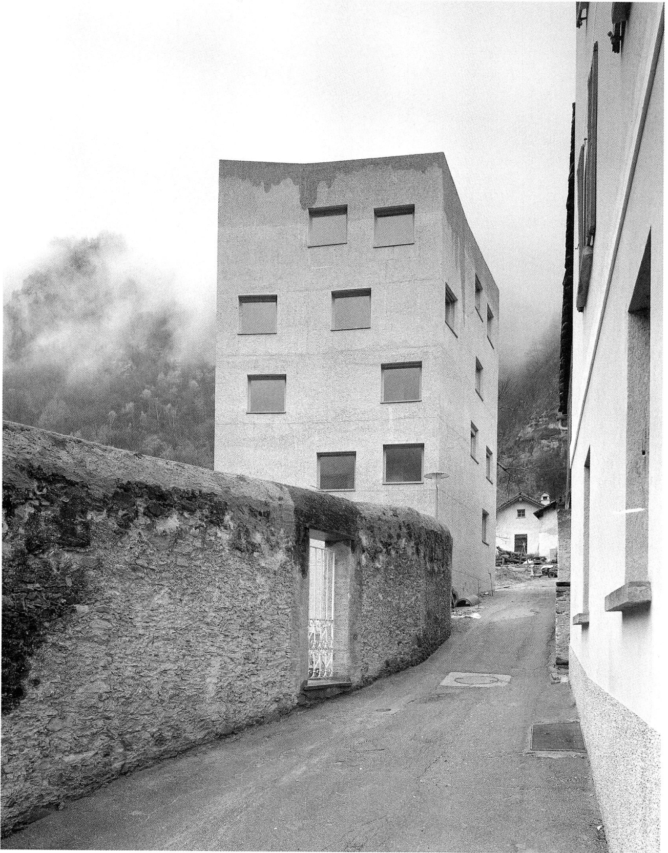
Neubau Garbald, der Turm an der Seitengasse. (Foto: Ruedi Walti, Basel, 2004.)
