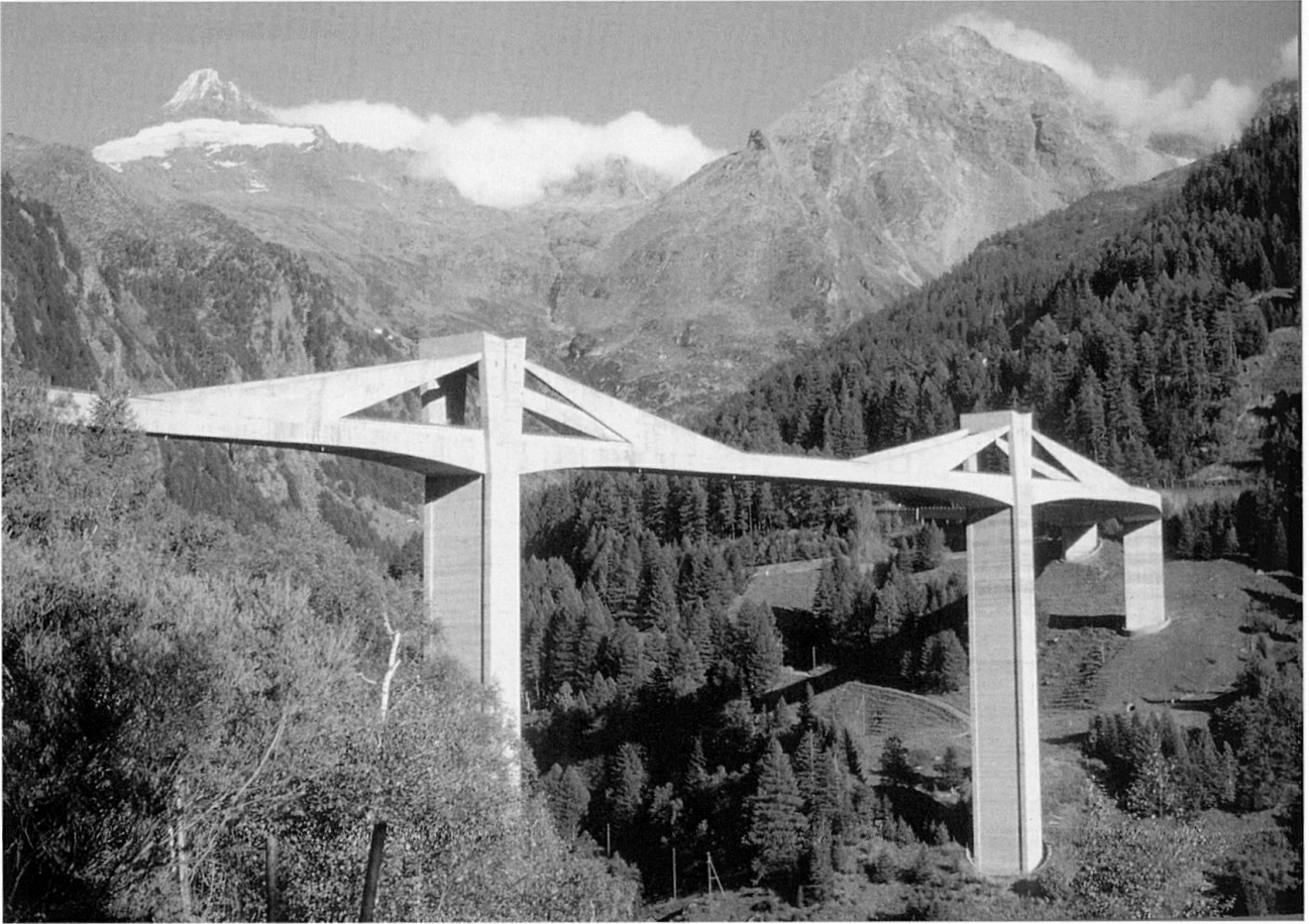
Ganterbrücke auf der Simplonstrasse von Christian Menn 1982. Die Zugseile, die der Kragkonstruktionsweise dienen, sind in den seitlichen «Wangen» eingebettet. Sie machen das formal Überraschende an dieser Konstruktion aus. Die Erklärung der Form bezieht sich jedoch auf eine Umkehrung der Form von Maillarts Tavana-sabrücke aus dem Jahr 1905. So frei verfährt der schöpferische Ingenieur mit seinen Vorbildern. (Bild oben aus: Gesellschaft für Ingenieurbaukunst, Thomas Vogel und Peter Marti (Hrg.), Christian Menn. Brückenbauer, Basel 1997, S. 66.) (Bild rechts aus: David P. Bollington, The art of structural design. A swiss legacy, New Jersey 2003, S. 184.)
