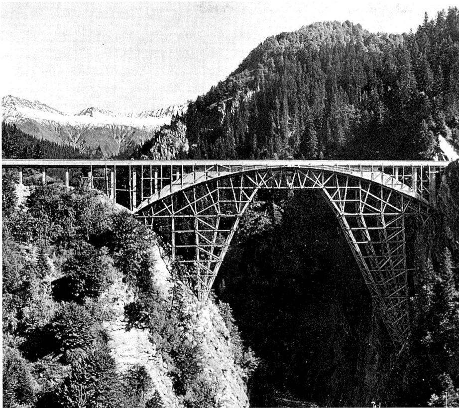
Die vollendete Salginatobelbrücke anfangs August 1930 vor der Absenkung des fächerförmigen Lehrgerüsts von Richard Coray (aus: Andreas Kessler, Vom Holzsteg zum Weltmonument. Die Geschichte der Salginatobelbrücke, Schiers 1996, S. 123.)
