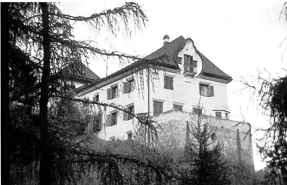
Abb. 1: Sent, Haus Zisler/Crastan, 1922 (BV 488). Architekt: Iachen Ulrich Könz. (Fotos: Kantonale Denkmalpflege Graubünden)
